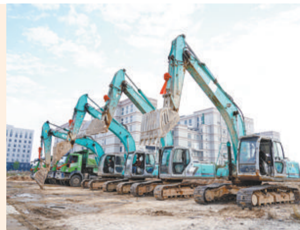
▲昨日,厦钨新能海璟基地锂离子电池材料扩产项目开工现场。
