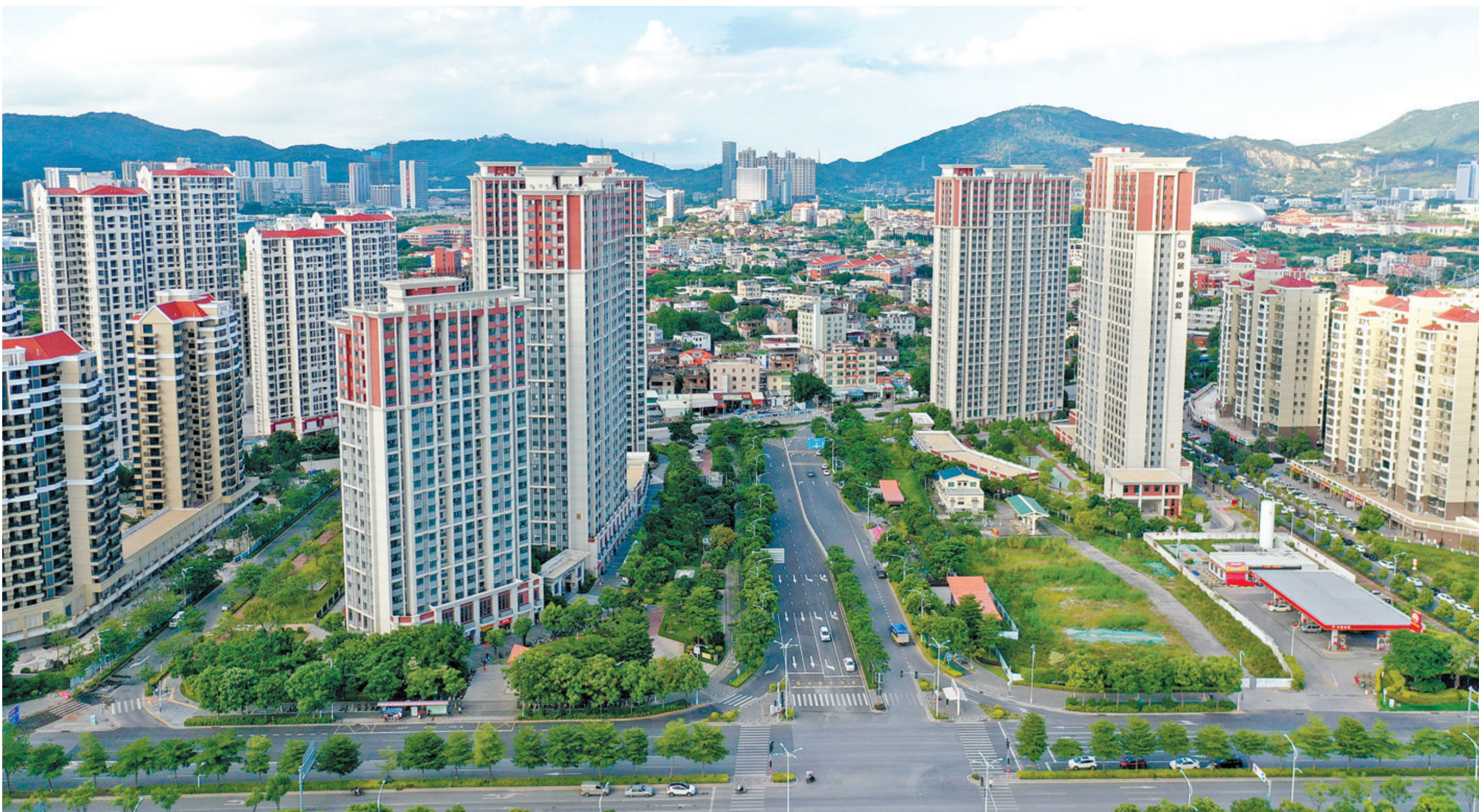
安居集团大力推动我市保障房建设工作,图为正在建设中的珩琦公寓。(本版图/安居集团 提供)
