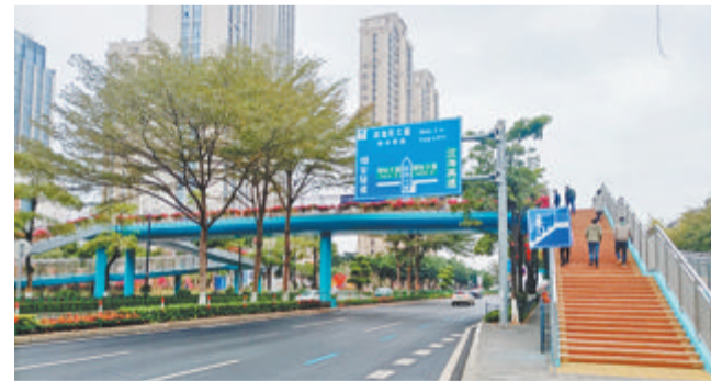
祥福路汇景商城人行天桥项目顺利通过预验收并投入使用。
