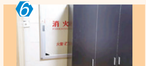
6 测评项目:“回头看”小区 测评点位:湖里区源昌鑫海湾 测评情况:该点位主要存在楼道内乱堆杂、乱摆放,楼道墙面、设施破损,乱悬挂、乱晾晒,飞线充电,非机动车乱停放和垃圾落地、积存等问题,测评成绩71.00分(11月份测评成绩75.00分)。
