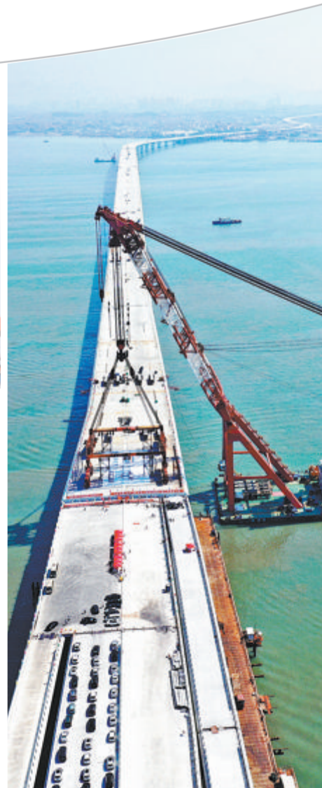
▲2022年9月12日上午，翔安大桥主线成功合龙。(本报记者 王协云 航拍器摄)
