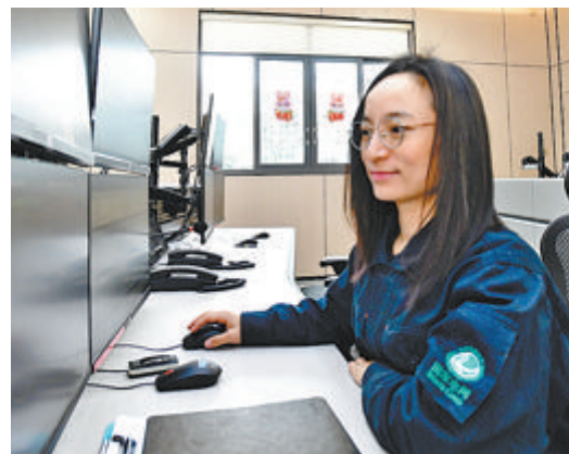
郑彬紧盯电脑屏幕,监控全市112座变电站的运行情况。(本报记者 张江毅摄)
