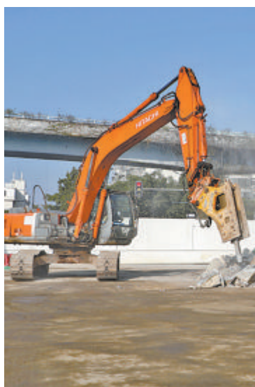
▲春节期间,在地铁6号线集同段第三医院站施工现场,建设者们坚守岗位,保施工进度。(本报记者 卢剑豪摄)
