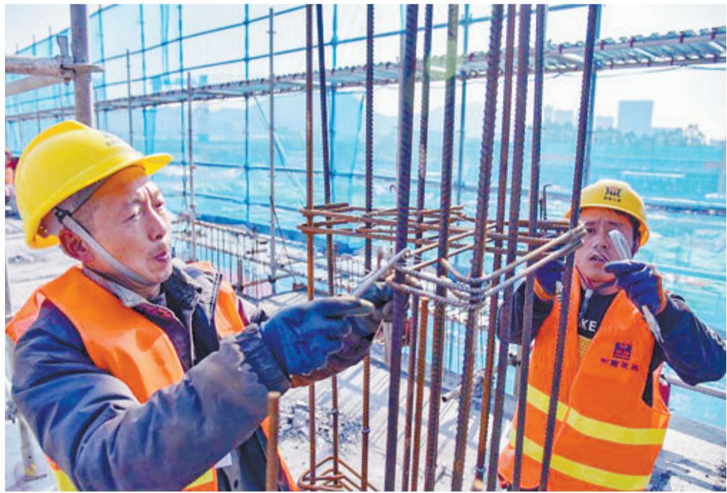
工人们坚守岗位施工,奋力保障工程进度。(林志杰 摄)
