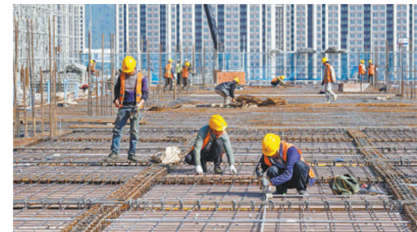
▲安捷利美维高端封装基板及高端HDI生产能力建设项目工地,一期项目主体建筑进入封顶冲刺阶段。(陈亚沙摄)
