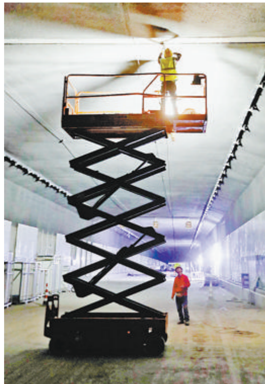
翔安大桥项目主线工程枋钟路隧道内,施工人员正在安装排水渠。
