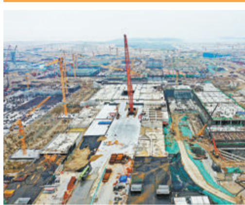
翔安机场核心区航站楼建设现场。
