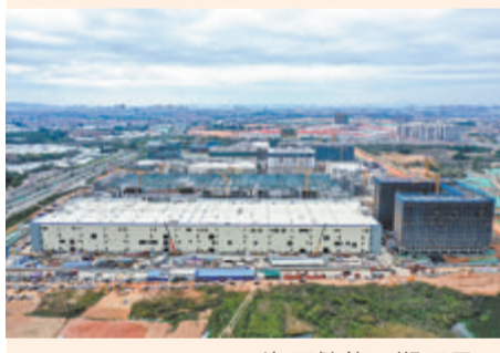
海辰储能二期项目。
