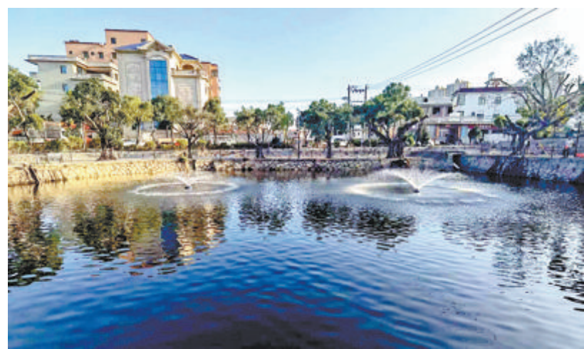
经过改造，桐梓社区的池塘休闲公园整体面貌焕然一新。
