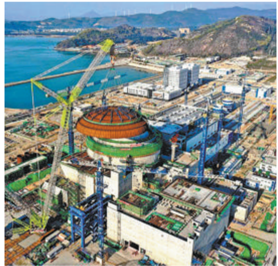
▲吊钩将外穹顶吊离地面,经过变幅、升钩、行走平移、调整等动作,平稳落钩就位。在反应堆厂房外层安全壳筒体上。(图/人民网)
