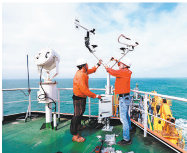
▲市气象局工作人员在海上工程作业船上安装国内首个5G专网船舶自动气象站。
