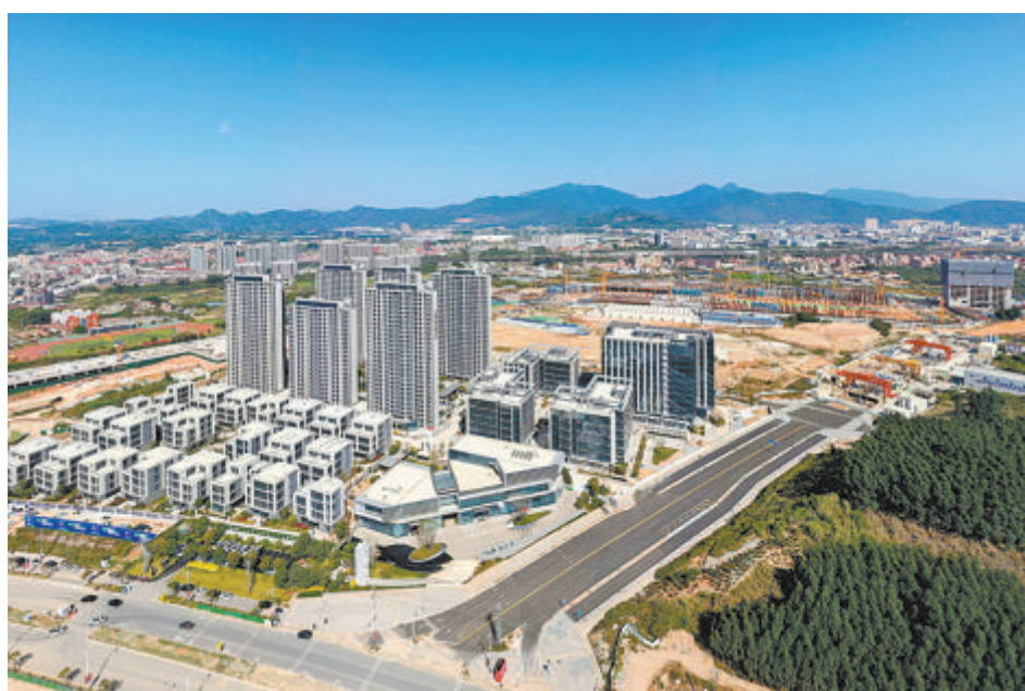
厦门地铁6号线角美延伸段TOD项目国贸智谷以及车辆基地正在建设中。
