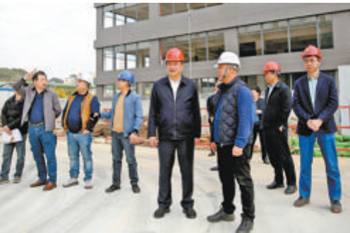
漳州台商投资区领导深入施工现场调研。(漳州台商投资区办公室 供图)
