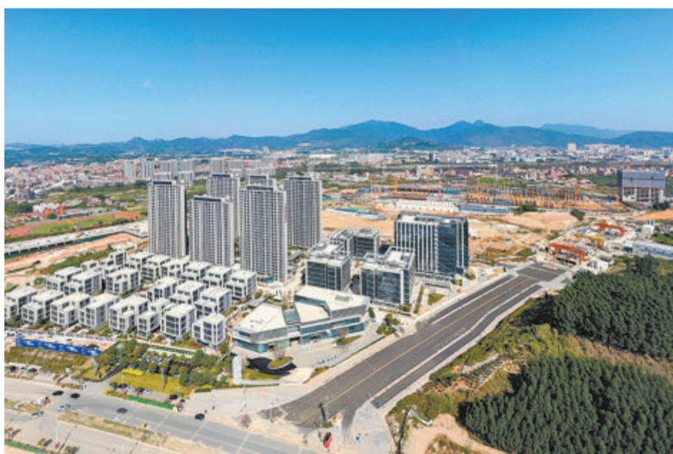
厦门地铁6号线角美延伸段TOD项目国贸智谷以及车辆基地正在建设中。
