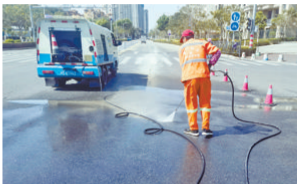
翔安市政保洁人员对路面洒落的水泥砂浆进行清理后,随即进行冲洗,快速保障道路交通恢复正常。
