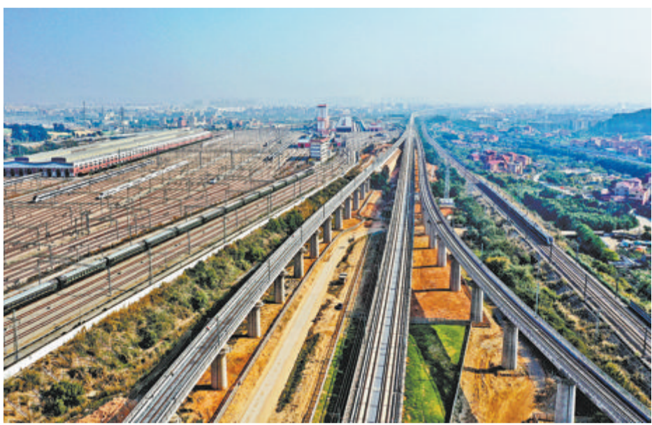
福厦高铁全线进入静态验收,图为福厦高铁8标进岛联络线。(本报记者 王协云 摄)
