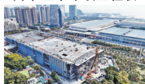
厦门国际会展中心五期混凝土主体结构近日全面封顶。(上海宝冶 供图)
