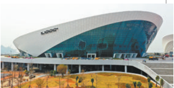
厦门凤凰体育馆正在进行投用前最后的优化提升,预计下周正式投用。
