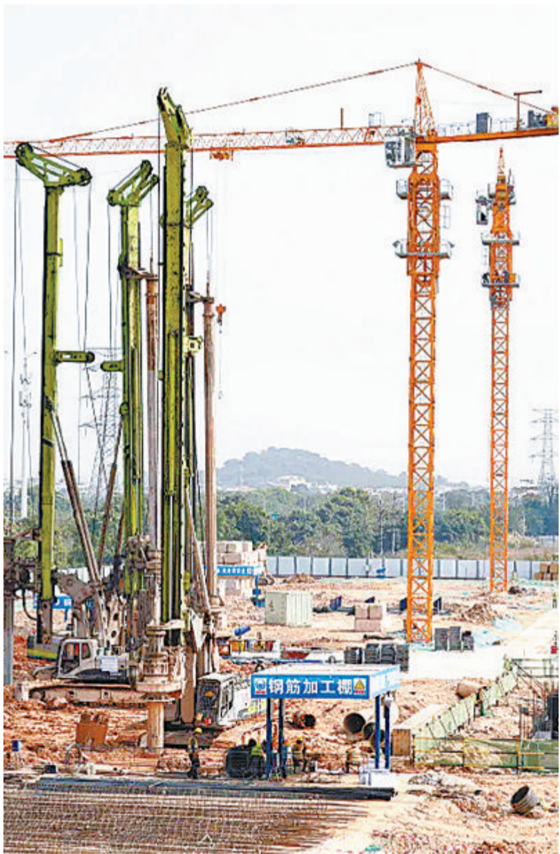
厦门生物医药产业园五期项目建设现场。(陈亚沙 摄)
