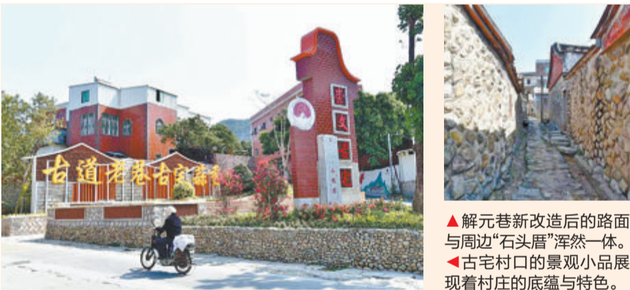
▲解元巷新改造后的路面与周边“石头厝”浑然一体。▲古宅村口的景观小品展现着村庄的底蕴与特色。
