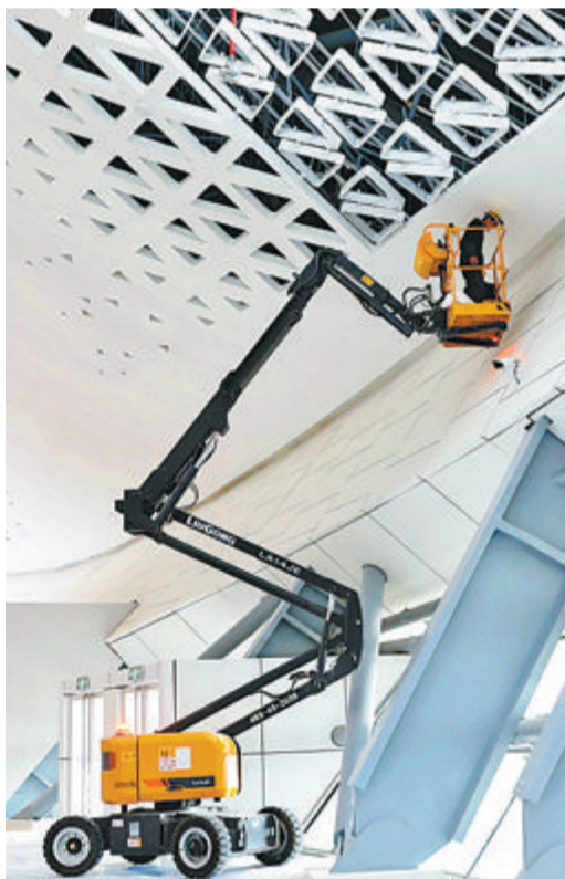
工人在凤凰体育馆安装电子设备。
