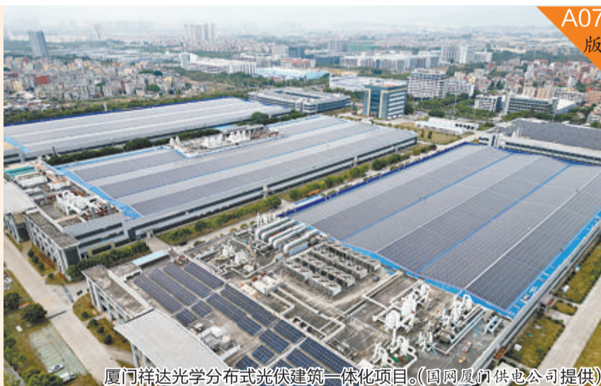
厦门祥达光学分布式光伏建筑一体化项目。(国网厦门供电公司提供)
