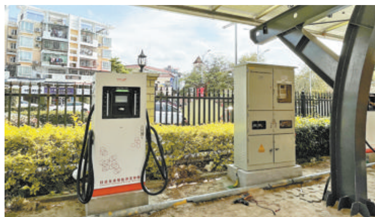
电动汽车可通过V2G充电桩向电网反向送电。
