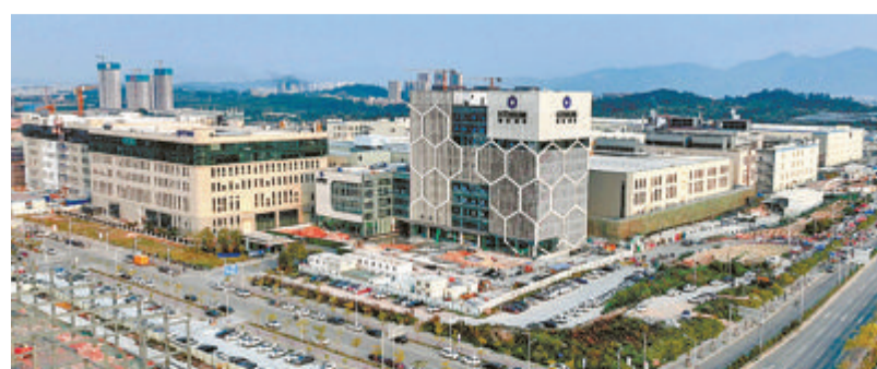
海辰储能厦门总部基地。
