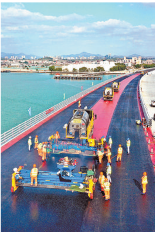
▲厦门新体育中心将成为重要的城市节点。 (本报记者 王协云 摄) ▼2022年11月9日,工人在翔安大桥项目海中段钢箱梁桥面上进行浇注式沥青铺设作业。 (资料图/本报记者 王协云 摄)
