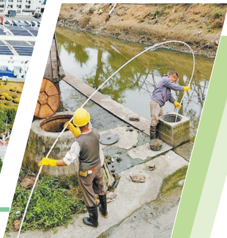
▼工人对白礁村河道的管道进行疏通清淤。
