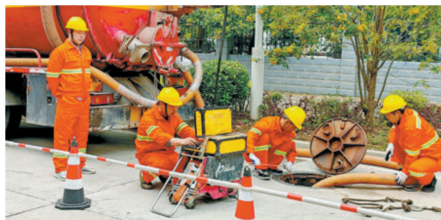
▲第三方技术人员对排水沟开展溯源排查。
