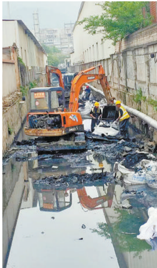
▲工人对龙池金山渠进行渠道清淤。
