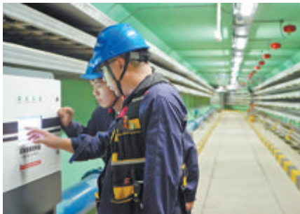
运维管理人员在地下综合管廊巡查。 (厦门市政集团 供图)
