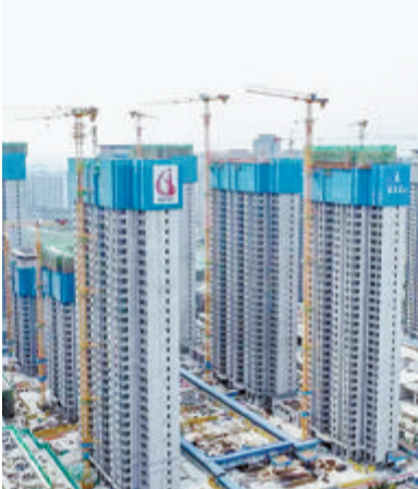
不久前主体结构封顶的新阳居住区三期。(市建设局 供图)
