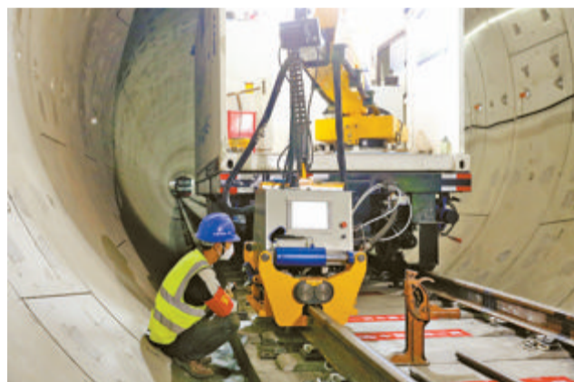
工人正在进行钢轨正火作业。
