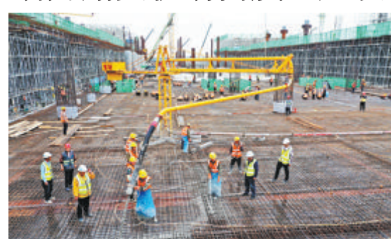
翔安机场片区迈入施工关键期。图为翔安机场航站区主体地下室主体结构顺利封顶浇筑。(本报记者 王协云 摄)
