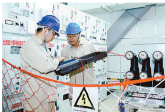
厦门新会展中心正式用电项目送电前，电力技术人员进行绝缘测试。（本报记者 卢剑豪 摄）
