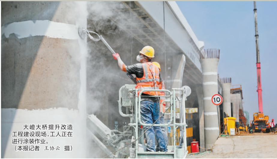
大嶝大桥提升改造工程现场,工人正在进行涂装作业。
