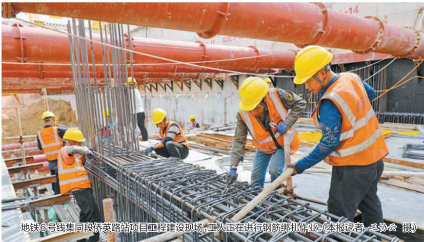
地铁6号线集同段侨英路站项目工程建设现场,工人正在进行钢筋绑扎作业。
