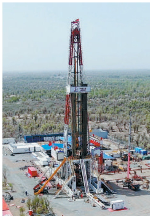
“深地一号”跃进3-3井施工现场。
