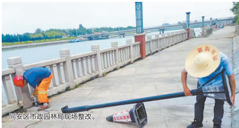
同安区市政园林局现场整改。
