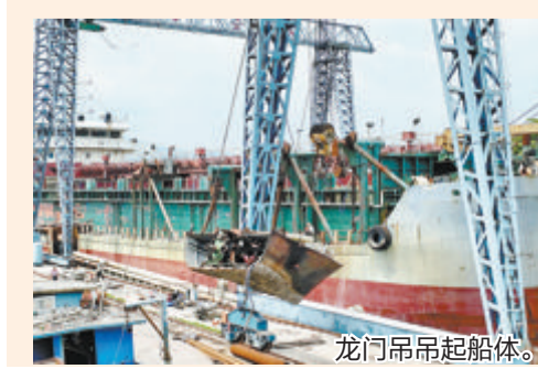
工人正在给船体打洞，以便起吊。
