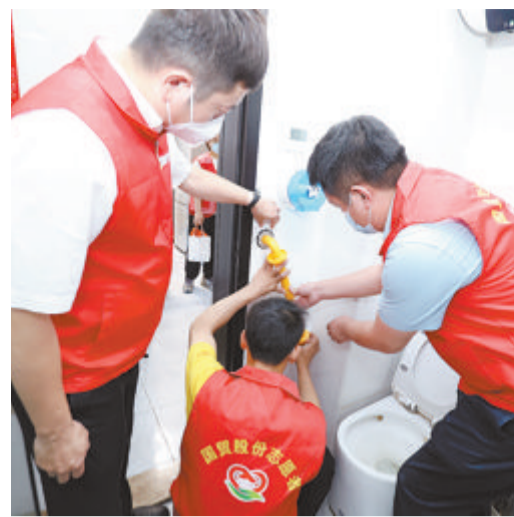
国贸股份志愿者走进老人家中,安装“黄扶手”。
