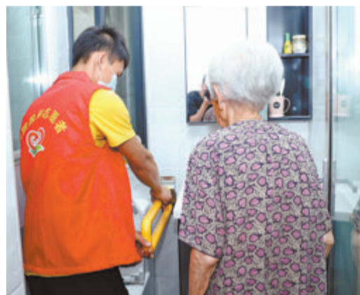
志愿者为高龄老人安装扶手。
