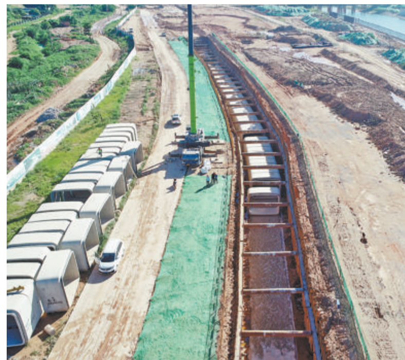
厦门持续推进地下综合管廊建设，助力城市高质量发展。图为马銮湾新城环湾大道（灌新路—柏涛路段）地下综合管廊施工现场。
