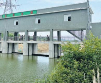
本报讯(文/图 通讯员 王晓青 记者 邵凌丰)6月2日,由翔安建发公司代建的马巷街道朱坑水闸拆除重建工程顺利通过合同工程完工验收并投入使用。马巷街道朱坑水闸拆除重建工程项目位于马巷街道内田溪与海翔大道下游交汇处以下15米位置,主要建设内容为拆除旧水闸、管理房及下游消能设施,新建上游铺盖段、闸室段和下游消能设施,总长47.5米。据了解,这个项目作为厦门市雨洪增蓄规划中翔安区第一个改造的水闸,备受关注。翔安建发公司党支部迅速成立“党员突击队”,由党支部委员挂钩项目,靠前指
