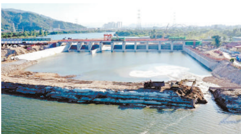
九龙江西溪水闸除险加固工程现场。
