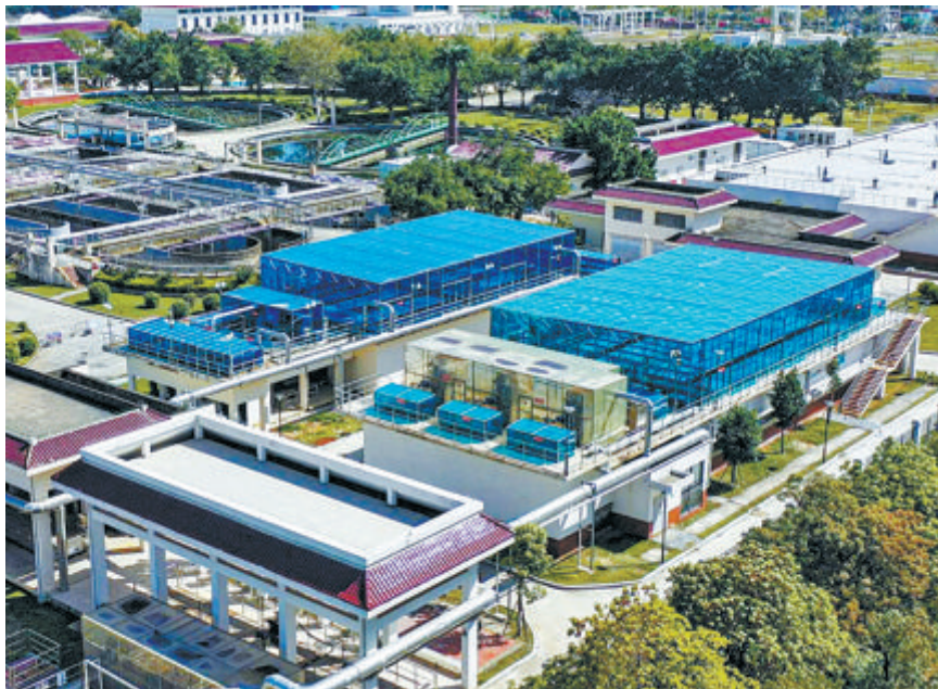
我市7座水质净化厂加装除臭设备,厂区空气质量得到改善。(市政环科公司 供图)
