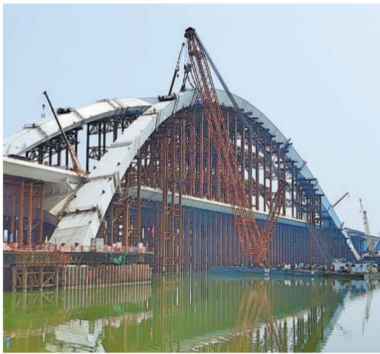
▲京雄大桥施工现场。
