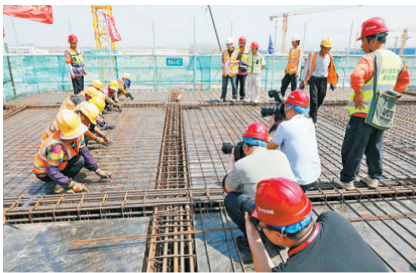
昨日，媒体记者走进厦门翔安机场热火朝天的建设现场采访。
