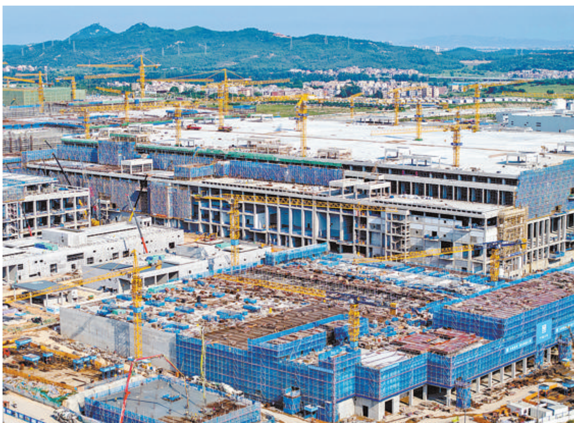
天马光电子第8.6代新型显示面板生产线项目建设现场热火朝天。(本报记者 王火炎 航拍器摄)
