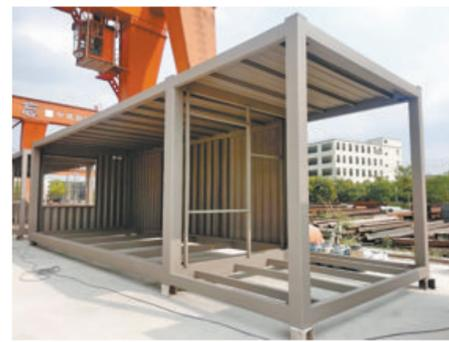
这是一个标准教室箱，在经过后续箱体装修等工序后，将在现场组装为建筑整体。(市建设局 供图)
