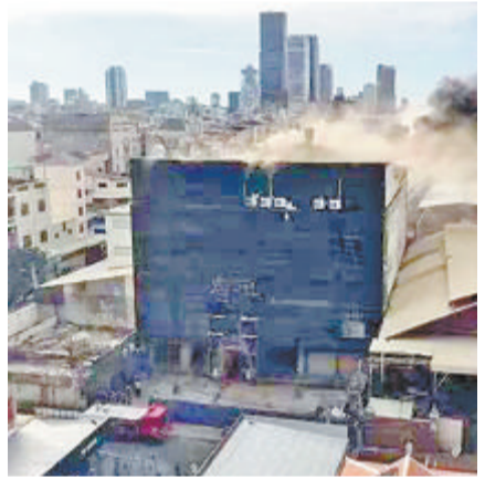
火灾致夜总会墙面被熏黑。(图/央视新闻)
