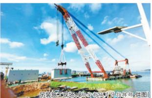
本报讯(记者 邵凌丰) 近日,起吊能力达700吨的 起重船开到目标地点,首件 沉箱顺利完成起吊出运并 安装至设计点位。这标志 着翔安新城片区厦门奥林 匹克体育中心码头区域岸 壁和停车场工程(岸壁专项 工程)沉箱预制及安装的流 水作业施工正式展开。
