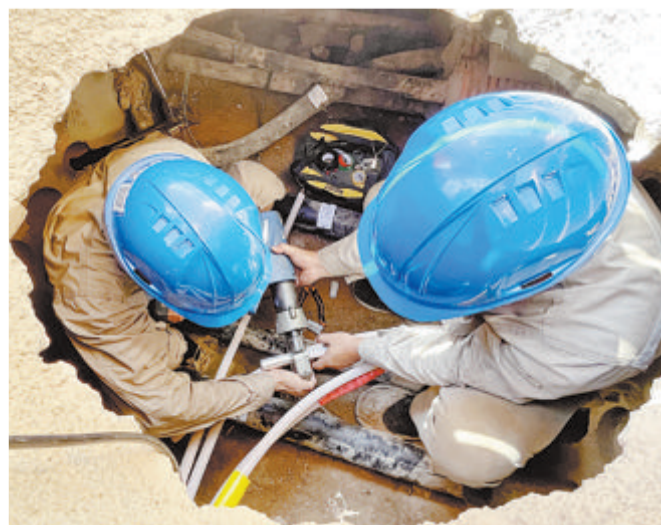
▲电力工人在地下1米深的狭小空间工作。
