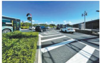
合流处导流岛端头设置广角镜,并延伸设置导流线。(市交通局公路中心供图)
